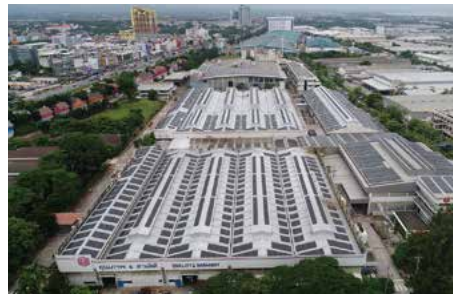
屋根を活用した太陽光発電システム
