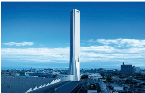
エレベーター試験塔[SOLAÉ(ソラエ)]
