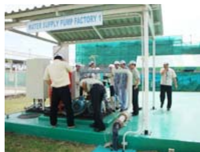
国内拠点での環境点検の様子
