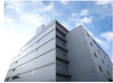
データセンター
