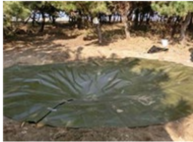
防水シートを敷いて埋め戻し
