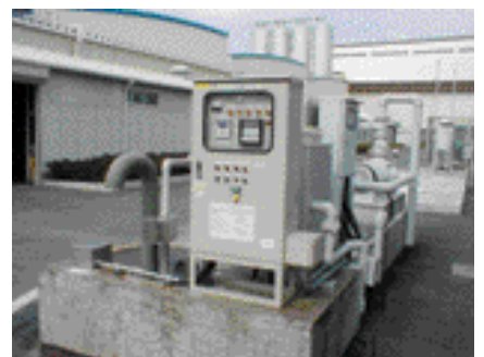
東洋高砂乾電池(株)が導入したpH中和処理装置 5) pH:ペーハー。pHの値が高いほどアルカリ性。
