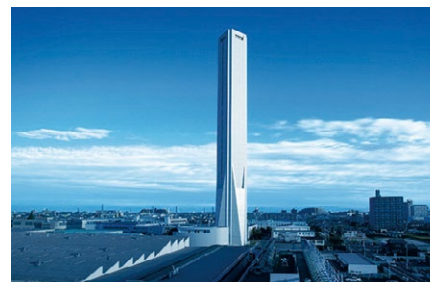
エレベーター試験塔[SOLAÉ(ソラエ)]
