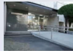
玄関スロープと自動扉
