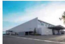
真空バルブ・遮断器工場
