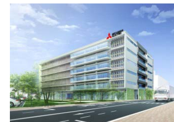
冷熱システム製作所 「技術棟」建設
