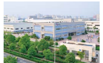
中国・株洲 株洲時菱交通設備有限公司 ● 中国国内工場の生産拠点 制御装置、補助電源装置 他 ● エンジニアリング・設計機能 ● 中国でのアフターサービス
